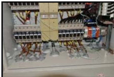
온도 상승 시험 ( TC 센서 측정 )
